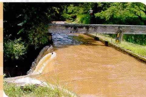
Canal de Conducción San Gil
