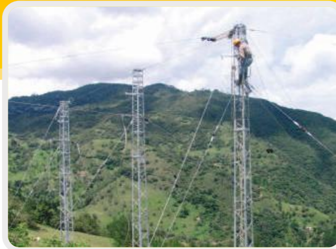
Construcción línea 34.5 KV Matanza-California
