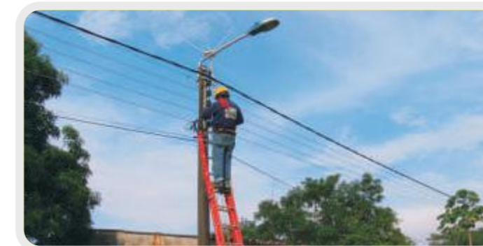
Remodelación red de baja tensión Barrio Colombia Barrancabermeja
