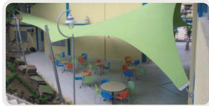
Remodelación Sede Social La Chispa
