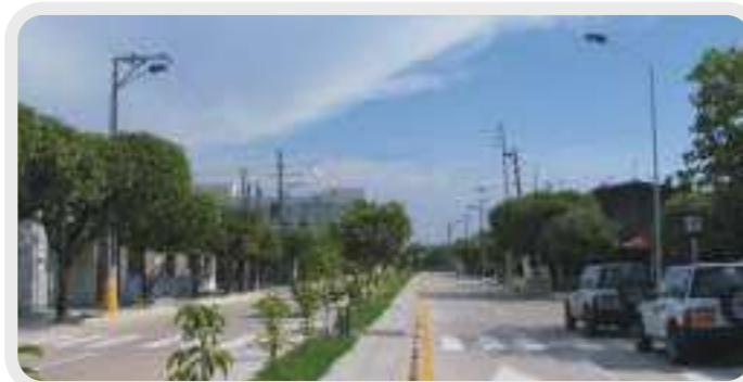
Remodelar redes en baja tensión de Barrancabermeja
