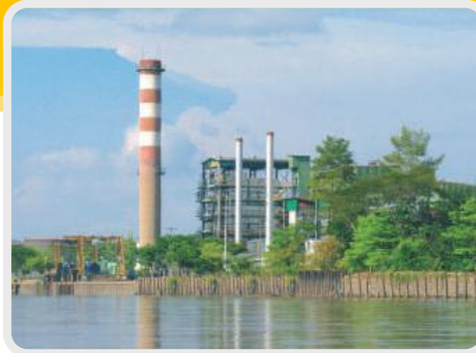
Panorámica Planta Termoeléctrica TERMOBARRANCA
