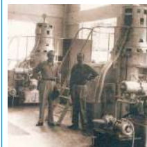
1941 Hidroeléctrica del Río Lebrija
