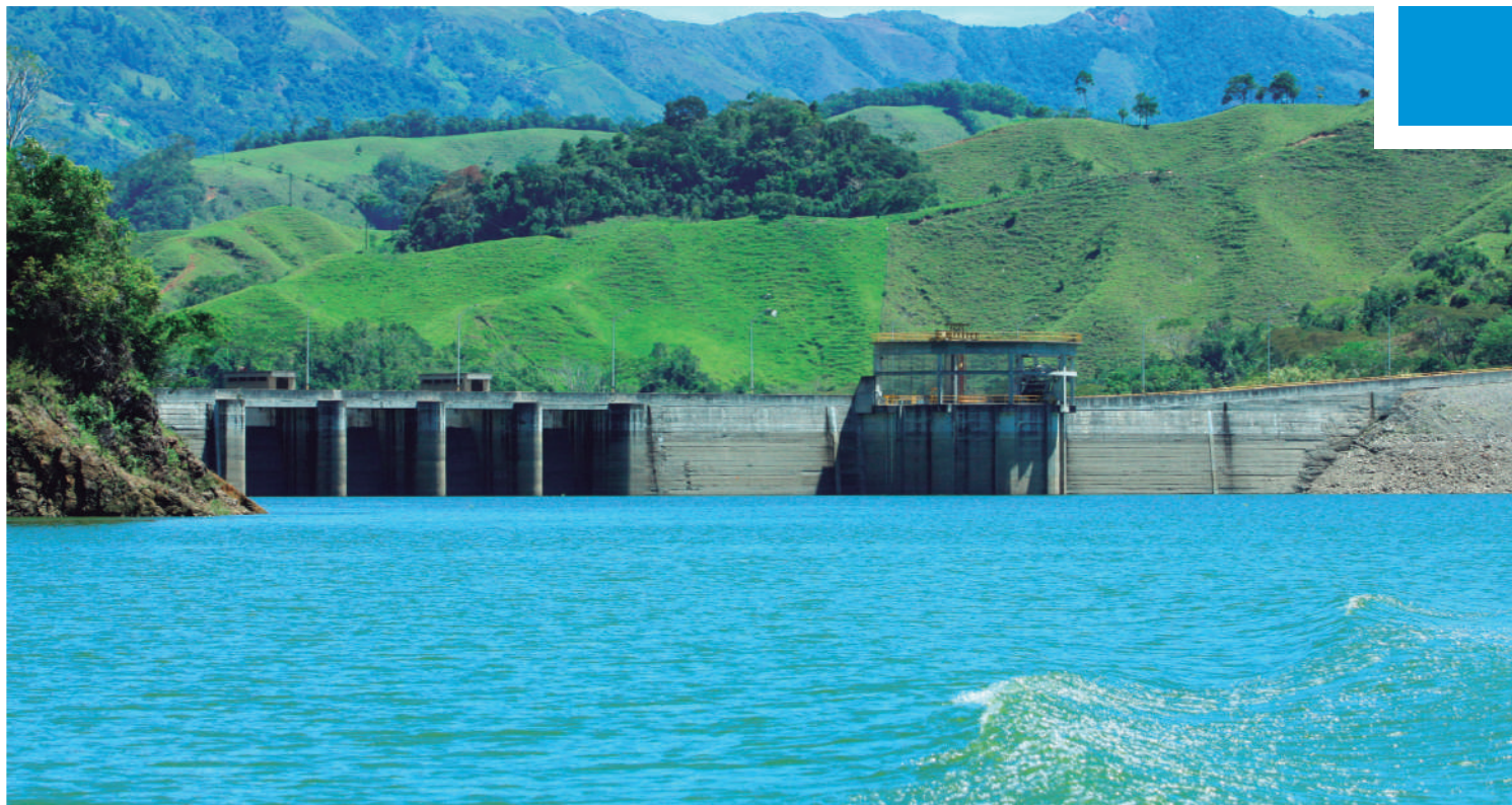
Porce III - Energía certificada como verde, proveniente de fuentes 100% renovables
