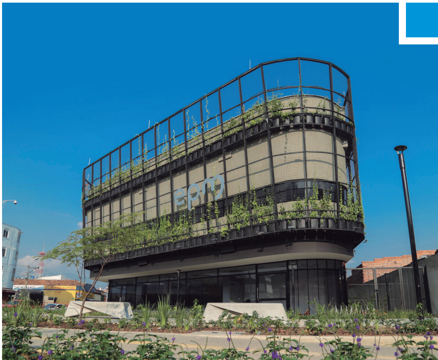
Distrito Término La Alpujarra -generación de energía térmica para climatización, único en Latinoamérica
